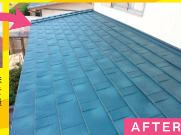
スレート瓦からルーガ鉄平にふき替え。重量はそのままだけに、見た目の高級感と耐久性が増しました。
